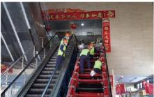
2022年12月20日至22日,5人安装 From December 20 to 22, 2022, a 5-person 组,以3天(50小时)的时间创造了一 个全新的保留桁架自动扶梯现场更新 的记录。根据现场情况,采用悬臂吊 嵌入模块,提升高度5.2米。
